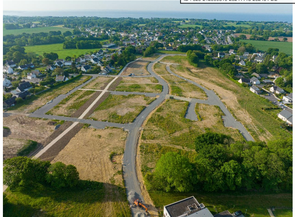
Vue aérienne Travaux de viabilisation - Secteur Sud de la ZAC Mai 2022
